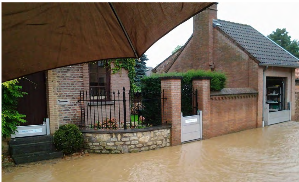
Batardeaux en action - Photographie Hydroprotect France
